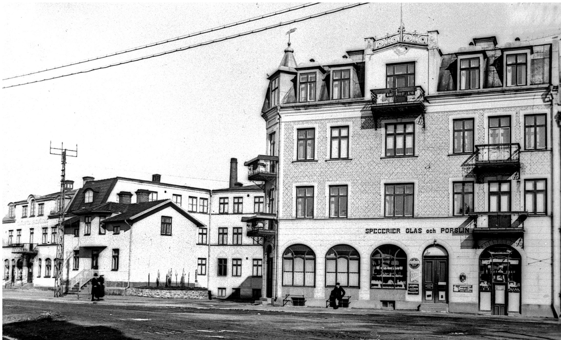
Sveagatan 1, Fundins fastighet uppförd omkring 1905. Konditoriet på hörnet ägdes och drev av Amanda och Edla Johansson med bageri i källaren och lägenhet en trappa upp. Nästa trappa gick in till Lindwalls Specerier Glas och Porslin, affärsinnehavare var Robert Lindwall som öppnade sin butiken 1907, 23 år gammal. Nästa hus till vänster en bit in på gården, är Storgatan 2 Oscar Wigéns fabrik.
