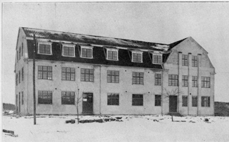
Exteriör av möbelfabriken.
