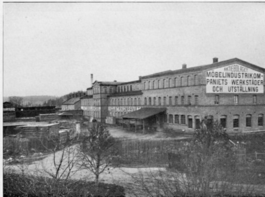
Exteriör av fabrikskomplexet.
