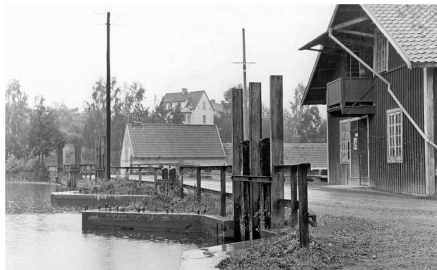
Vriggebodammen mot Åsvallehultsidan och elverket rakt fram.
