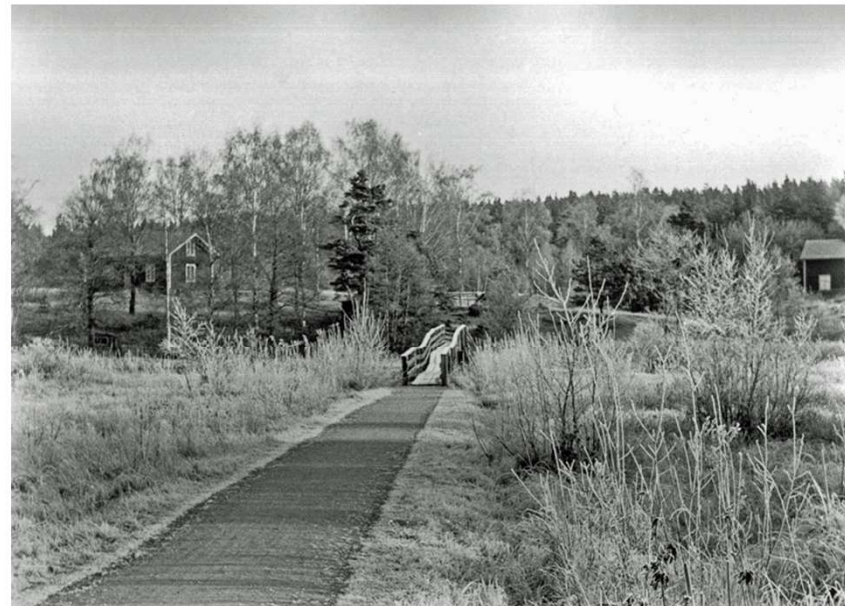
Bilden tagen från Östanå med den gamla bron som byggdes 1934 och ersattes 1972 med en ny bro. Till vänster ses torpet Damsängen och till höger Ljungstugan.
