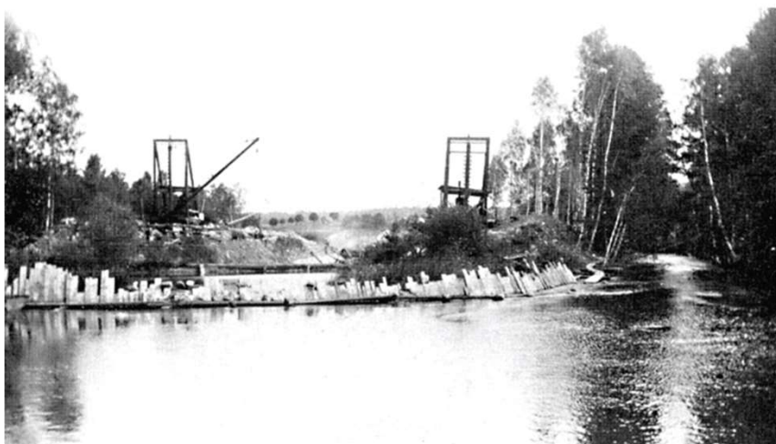
Grävningsarbetet strax väster om Haga gård.
