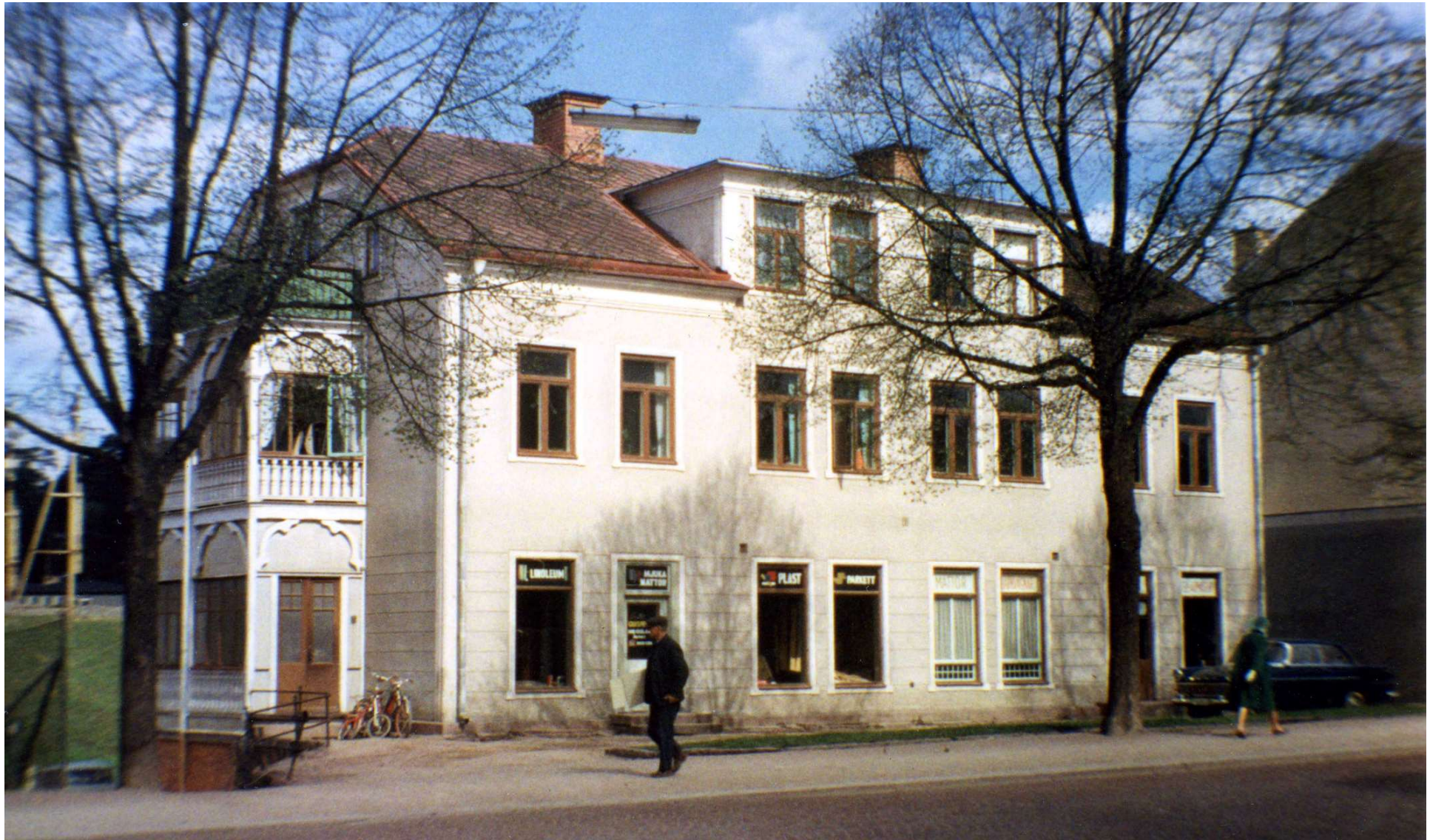
Storgatan 9 Kv. Plogen 7. Foto KE Jansson 1963.
