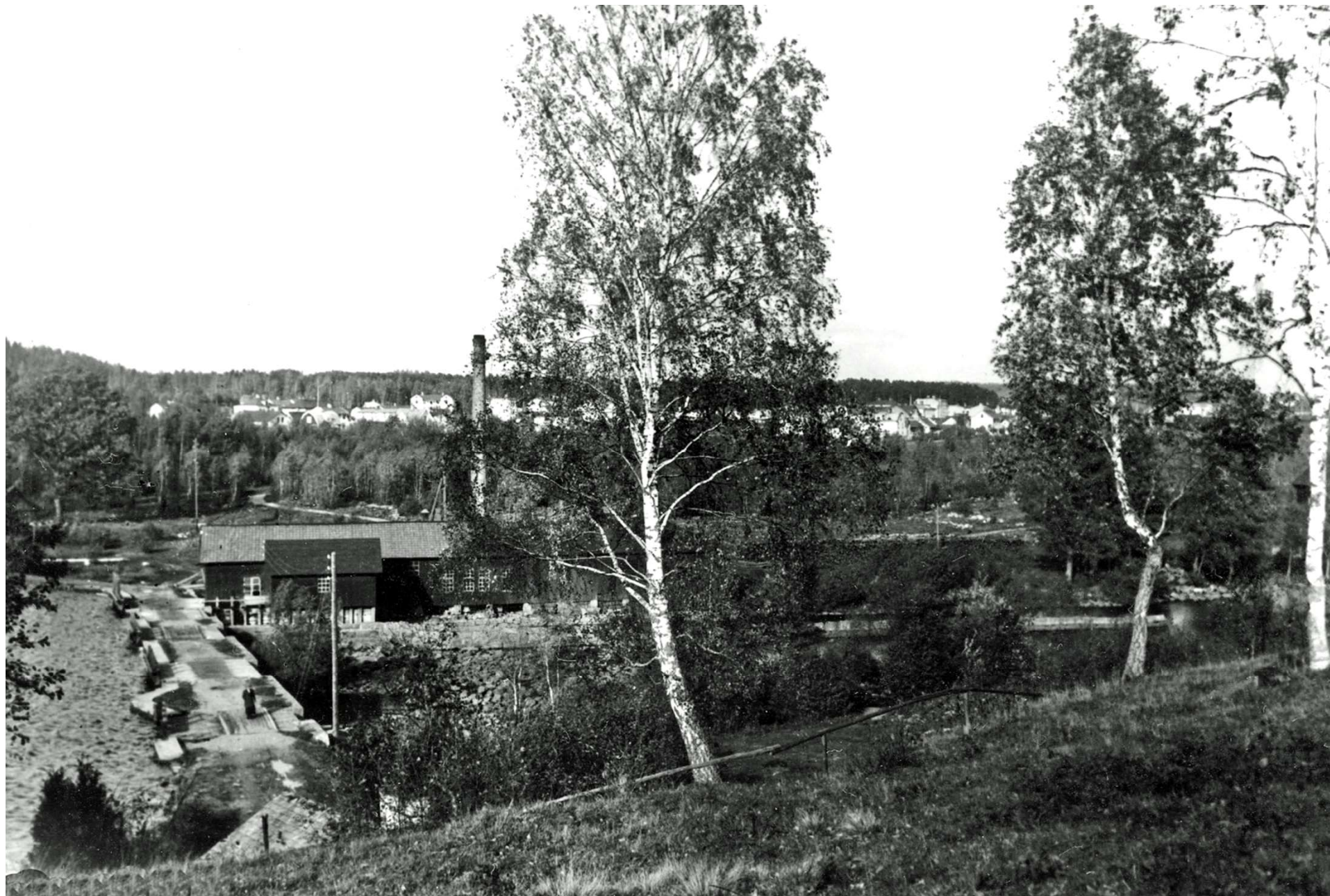
Åsvallehultsbron sett från Fröafallssidan med Tranås köping i bakkant. Väster om bron ligger C.A. Anderssons såg, ångcentral och elverk som såldes till köpingen c:a 1905.
