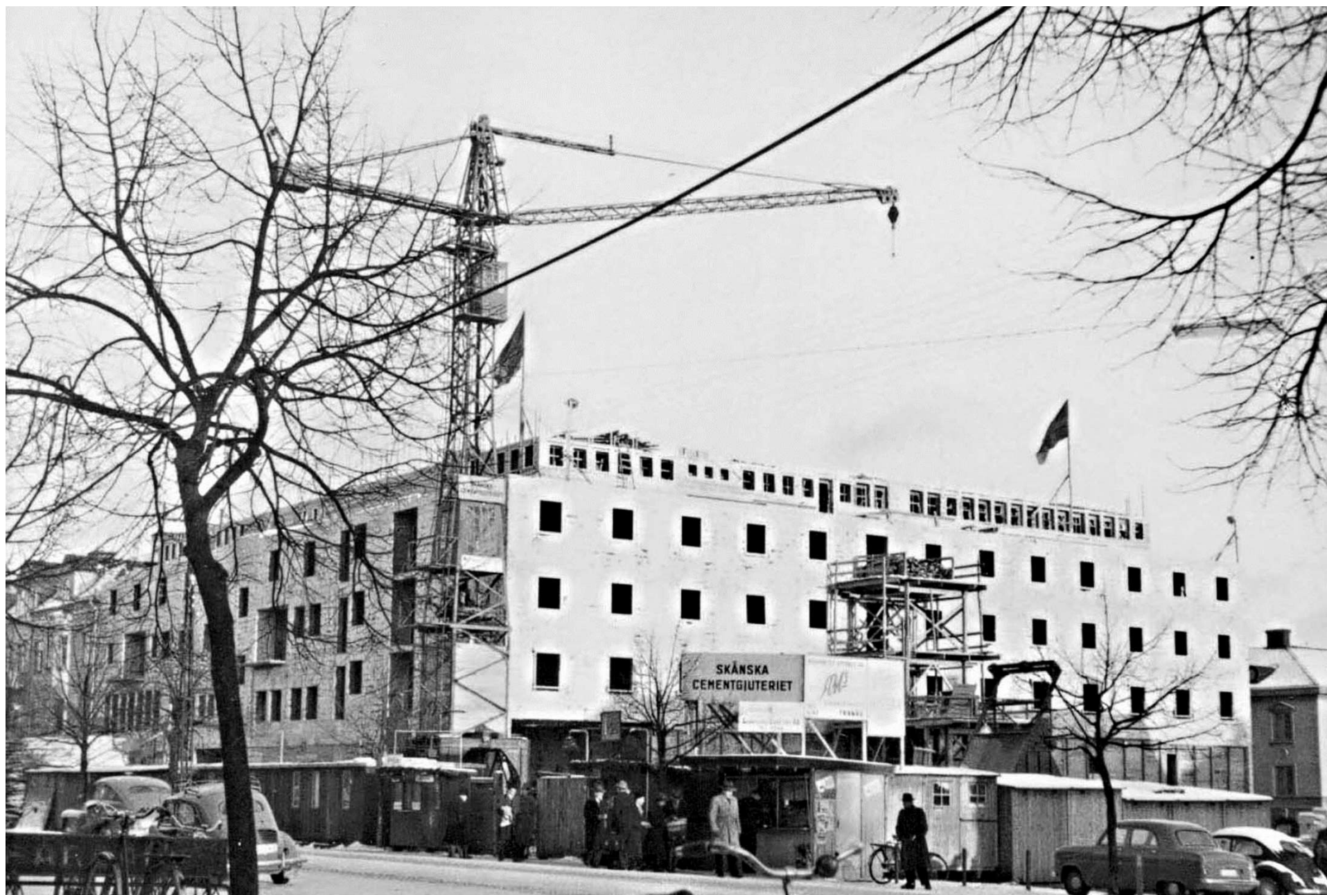
Stadshotellet har nu kommit så långt att byggnaden är under tak och på lördagen den 15 januari 1955 vajade tre svenska flaggor på det stora byggnadens tak.
