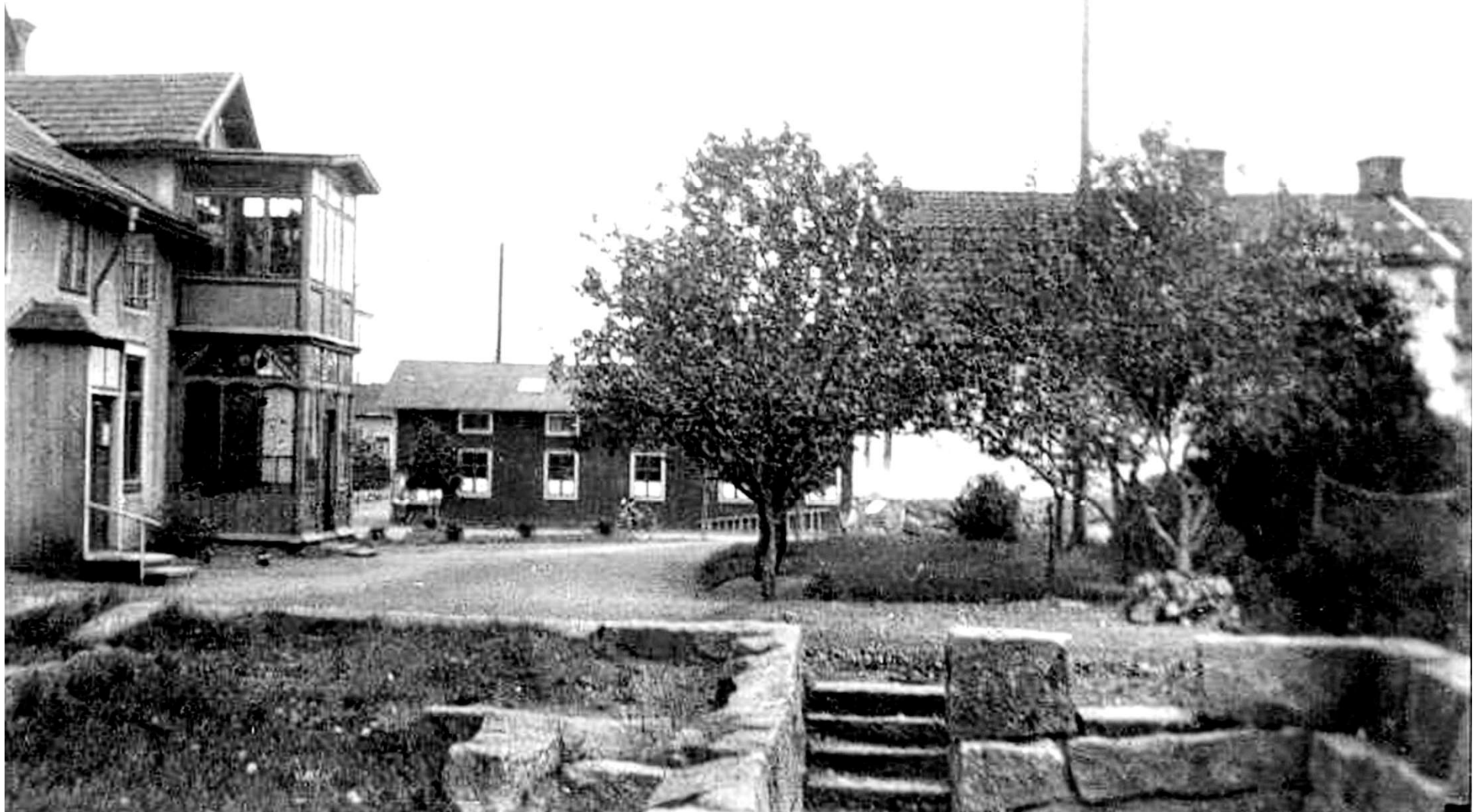
Storgatan 3 till höger och Storgatan 5 till vänster, i mitten på andra sidan Storgatan låg Korkfabriken, där nu Folkets hus ligger. Den stensatta källaren i förgrunden måste tillhöra något mycket gammalt hus som, mej veterligt, inte finns omnämnt i någon litteratur.
