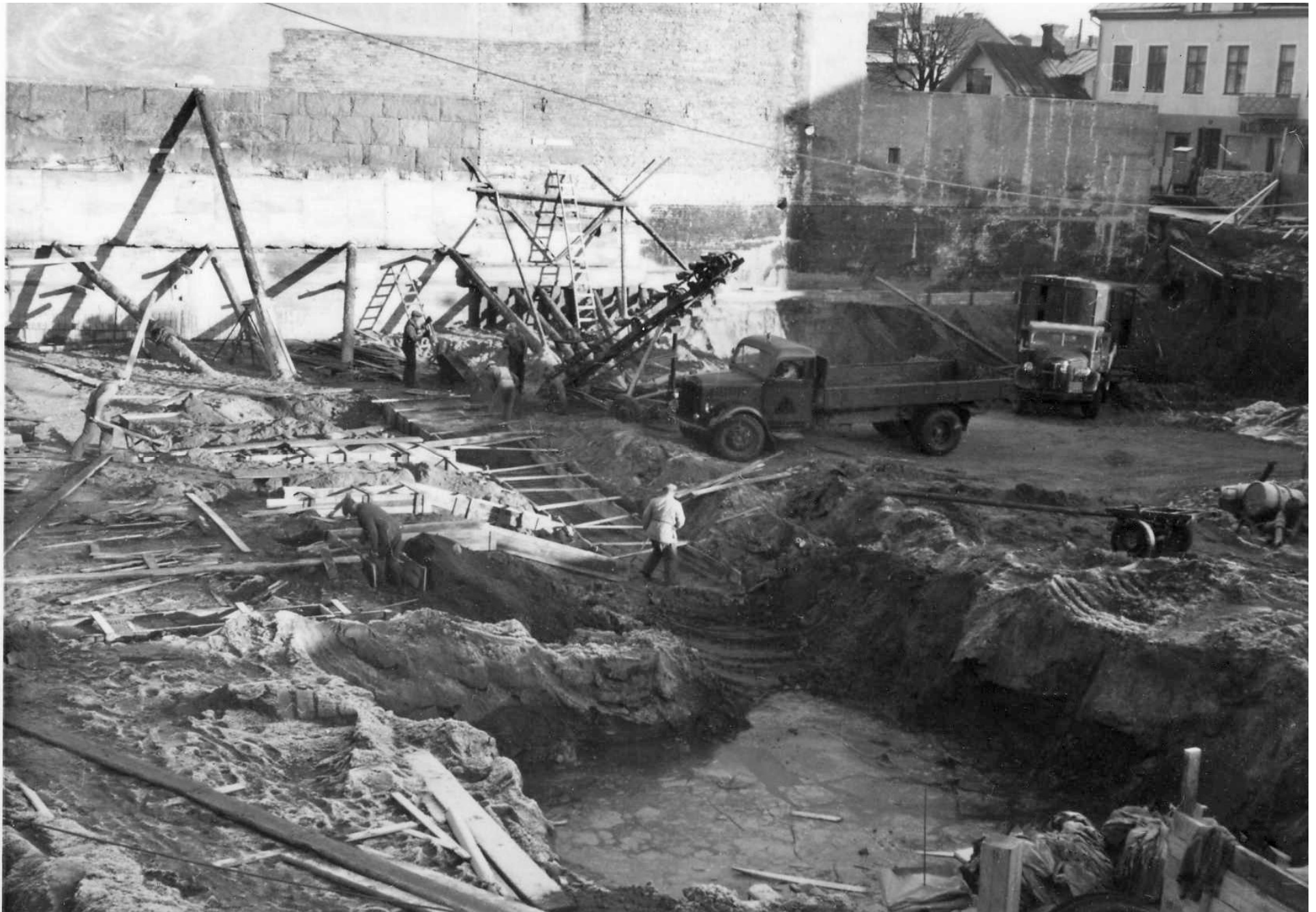
Innan all schaktning är klar började man med att stämma upp för bottenplattan.
