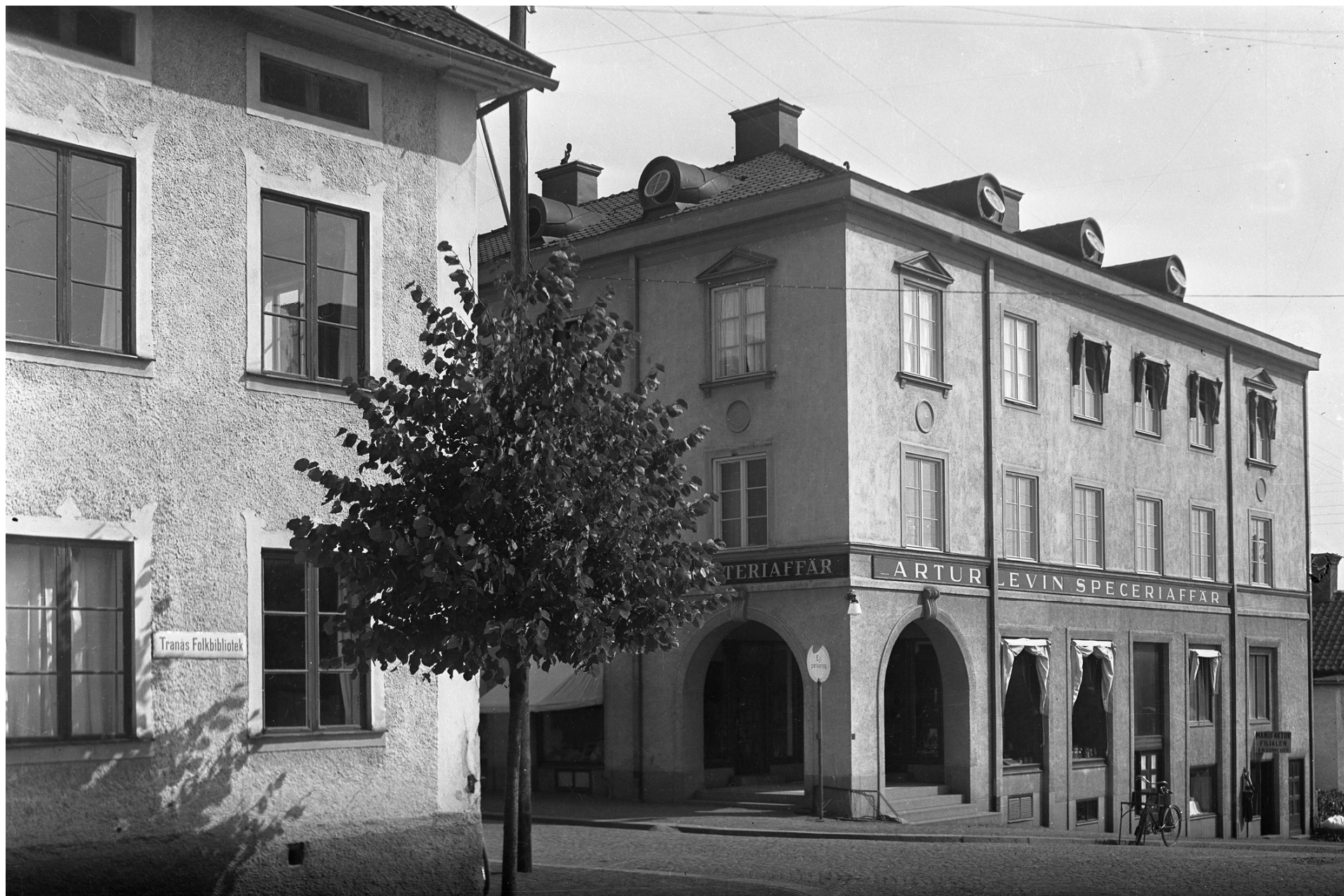
Ågatan 26 byggdes år 1926 av slaktare Axel Johansson, som i många år bedrev slakteri och charkuteriaffär i fastigheten. Affären övertogs av ÖAF, det har sedan varit flera olika verksamheter i lokalerna. Huset revs 1986 och här byggdes ICA Kvantum. Posten fick också nya lokaler i huset.
