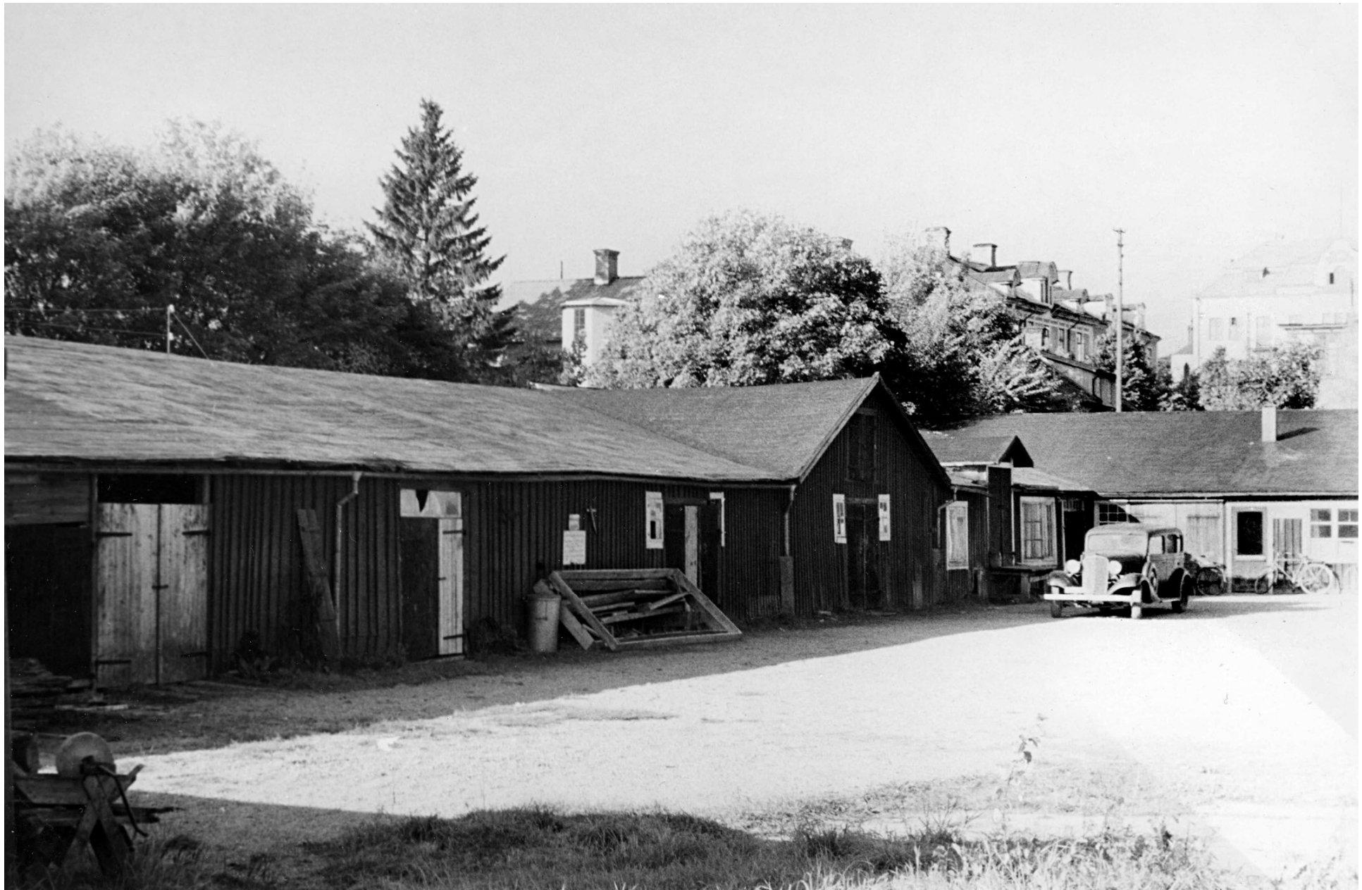
Södra Gyllenfors , söder om stadshusbron låg torgstallarna som torgknallarna ställde sina hästar medan de skötte kommersen på torget. I huset rakt fram hade Sand sitt åkeri med bostad och stallar. Där de gamla stallarna fanns står i dag Cityhuset.
