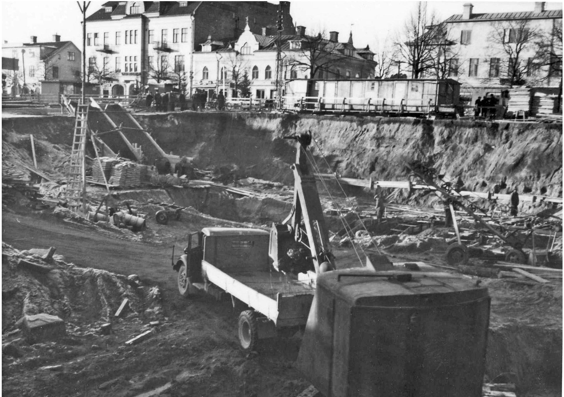
Här grävdes c:a 20 000 m 3 schaktmassor bort med hjälp av 5000 lastbilstransporter
