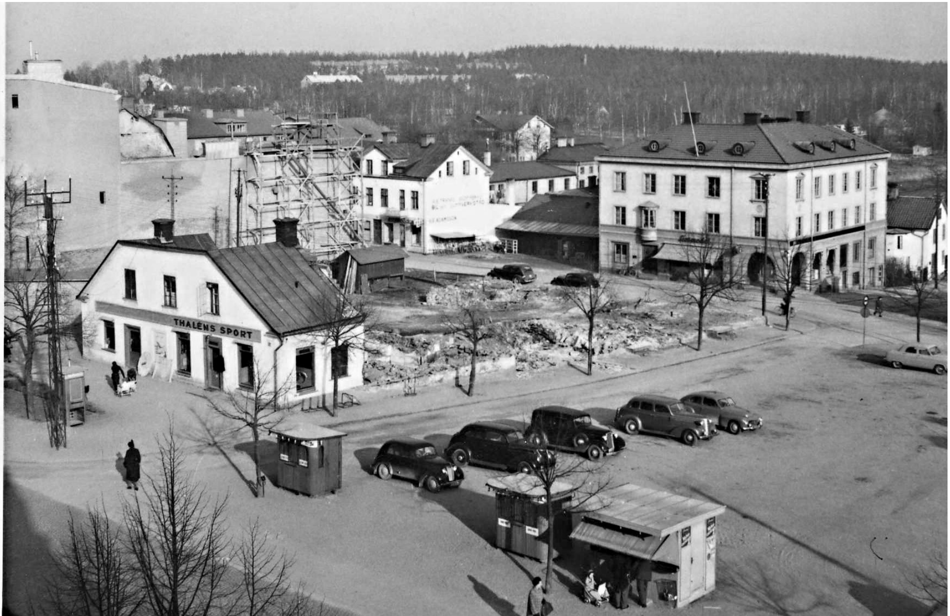
Framför den rivna fastigheten mot torget var Lövestads torghandel belägen redan på 1860 - talet och mot Storg. inrymdes Blaviers speceri - och manufakturaffär. I den rivna byggnaden har det även funnits en hotellrörelse, som serverade mat, vin och öl till hungriga och törstig Tranåsbor.
