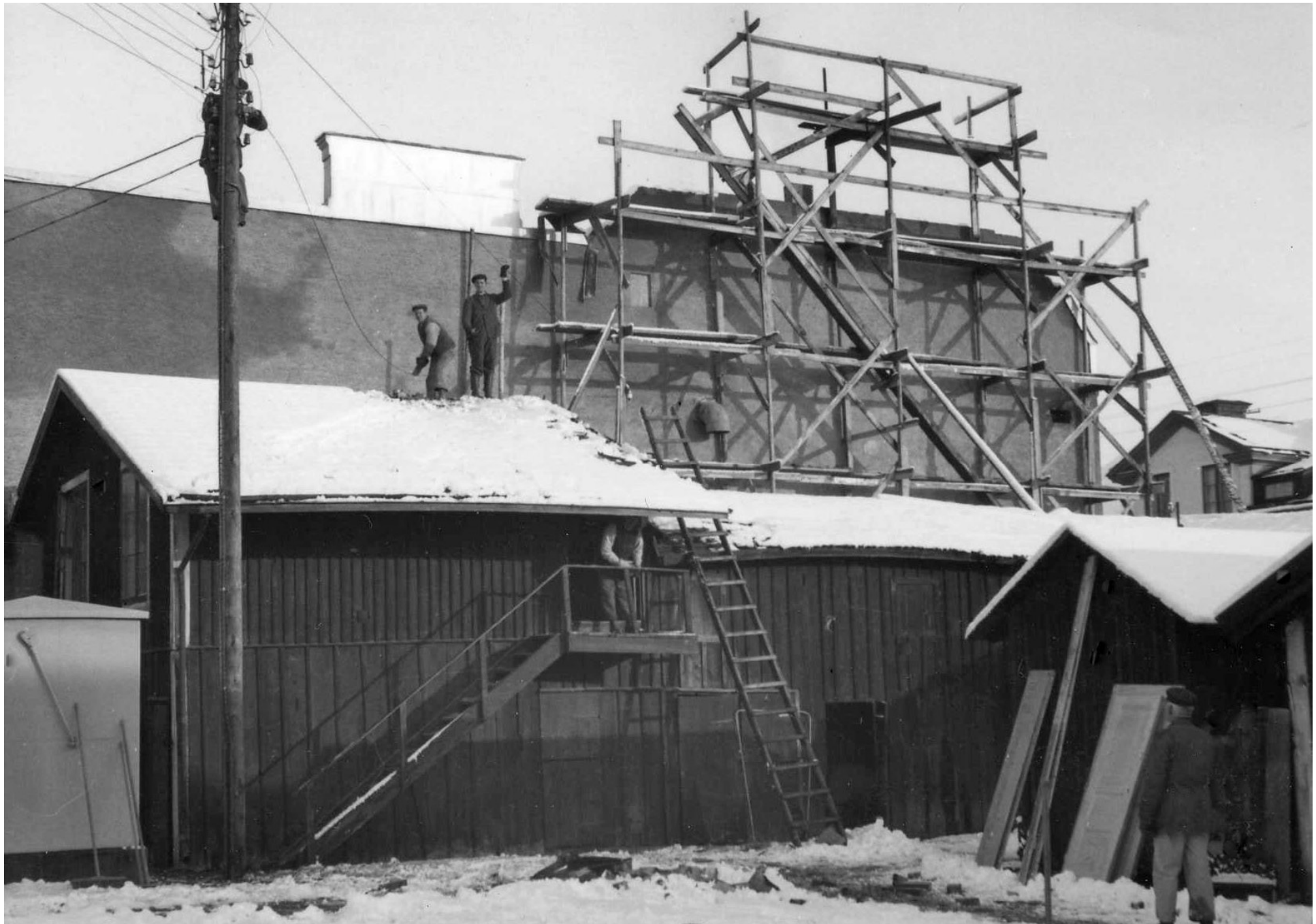
Rivning av kvarteret har börjat, det är nu vinter 1952 – 1953. Elledningar tas ner och bodar rivs.
