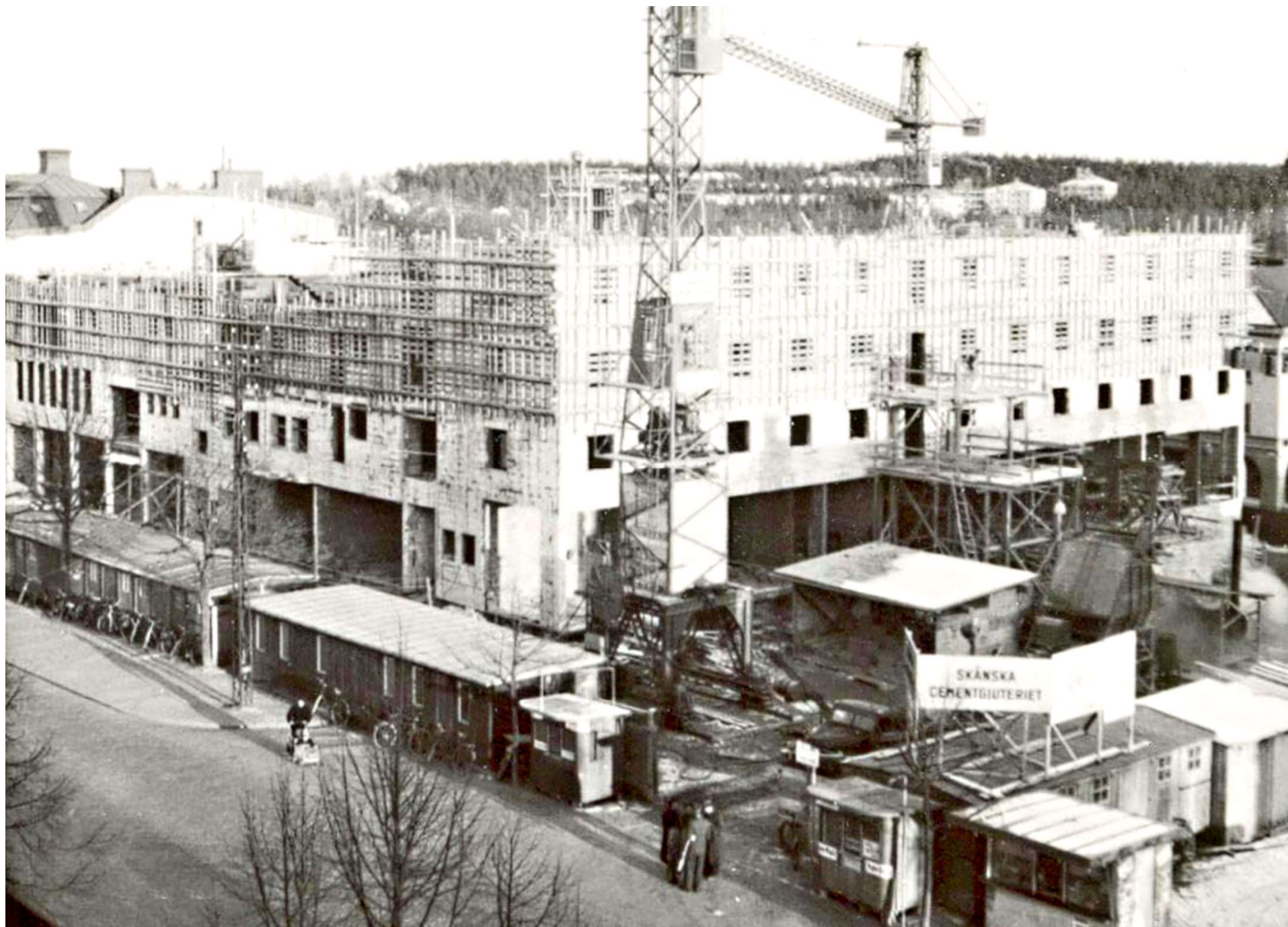
Nu är fjärde våningens fasad uppe och nu kan man faktiskt börja se hur stor byggnaden blir.
