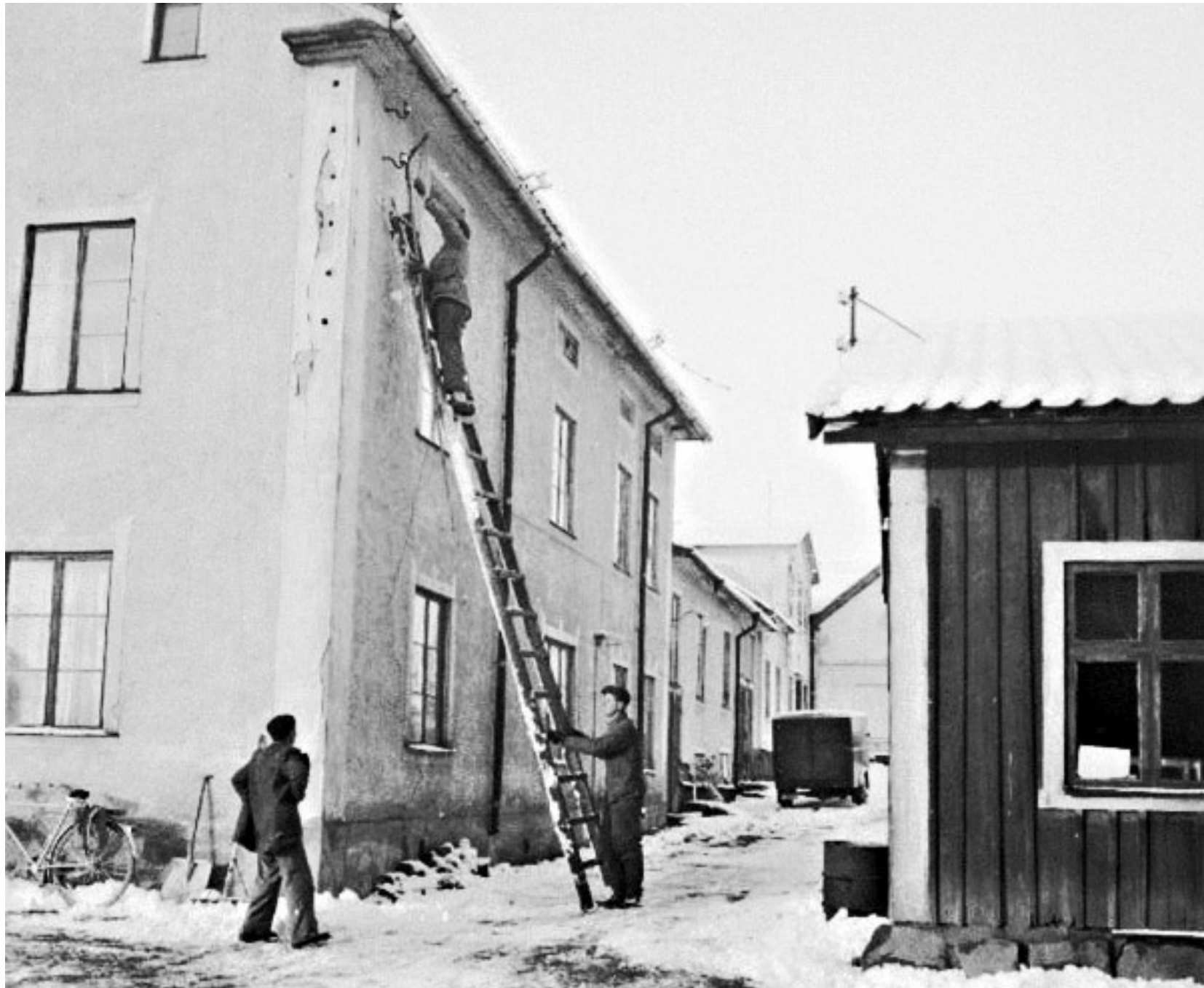
Rivningen av fastigheten som benämns som "kristidsnämnden", mot Ågatan, har börjat.
