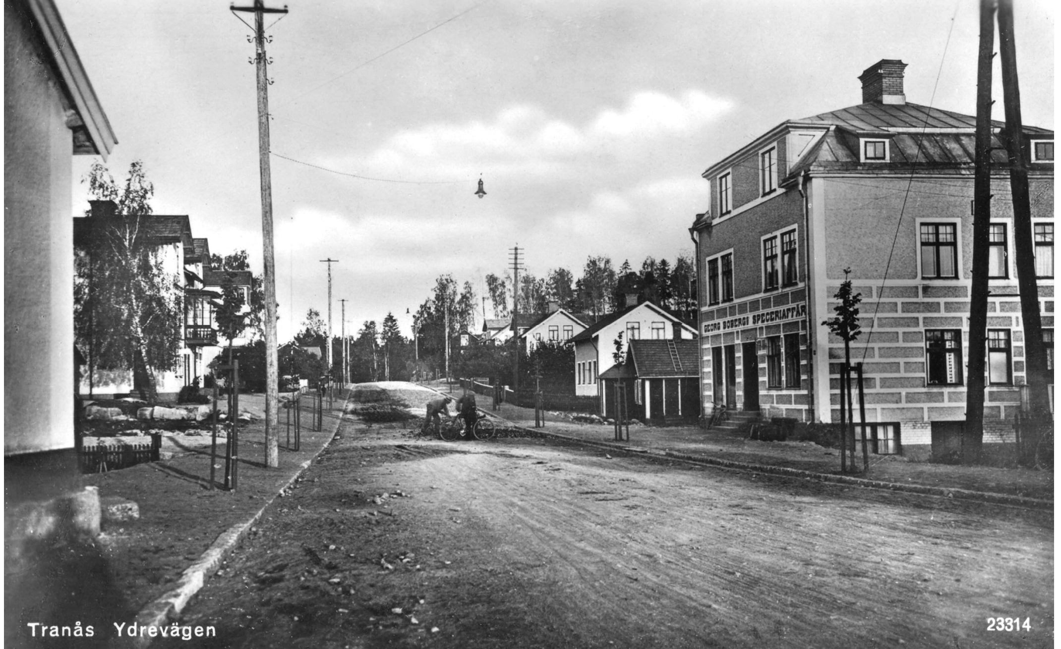
Till höger Ydrevägen 8, Georg Bobergs fastighet som fortfarande finns kvar. Ydrevägen 10, det lilla huset med gaveln mot vägen var en del av Ljungbergs smedja som låg in på gården med stallar och plats för 8-10 hästar. Därefter Ydrevägen 12, byggt 1895, och sedan smeden "Ljungbergs", som ännu står kvar (2009). Vykortet från början av 1920-talet
