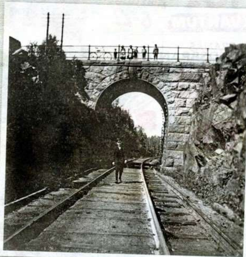
Stridabron söder om Tranås järnvägsstation.
