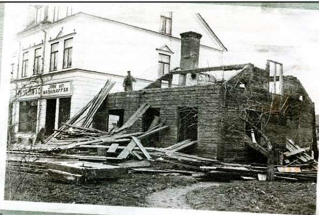
Änkefru Gyllenhammars fastighet på nuv. Storgatan 32 rivs efter det att AM:s Järnaffär blev färdig 1902
