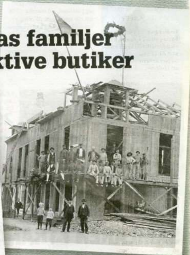
Malmqvists hus vid dåvarande Storgatan 23, byggdes om 1906 med en tillbyggnad. Det gamla huset stod kvar och byggdes in och fungerade som bostadshus under hela tillbyggnaden. Det kan vara Carl Malmqvist som står till vänster längst fram. Bygget igångsattes av Carl och fotografiet är taget från nuvarande Bankgatan inför taklägsfesten med unionsflaggan vajande på taket och färsk hästspilling på Storgatan.
