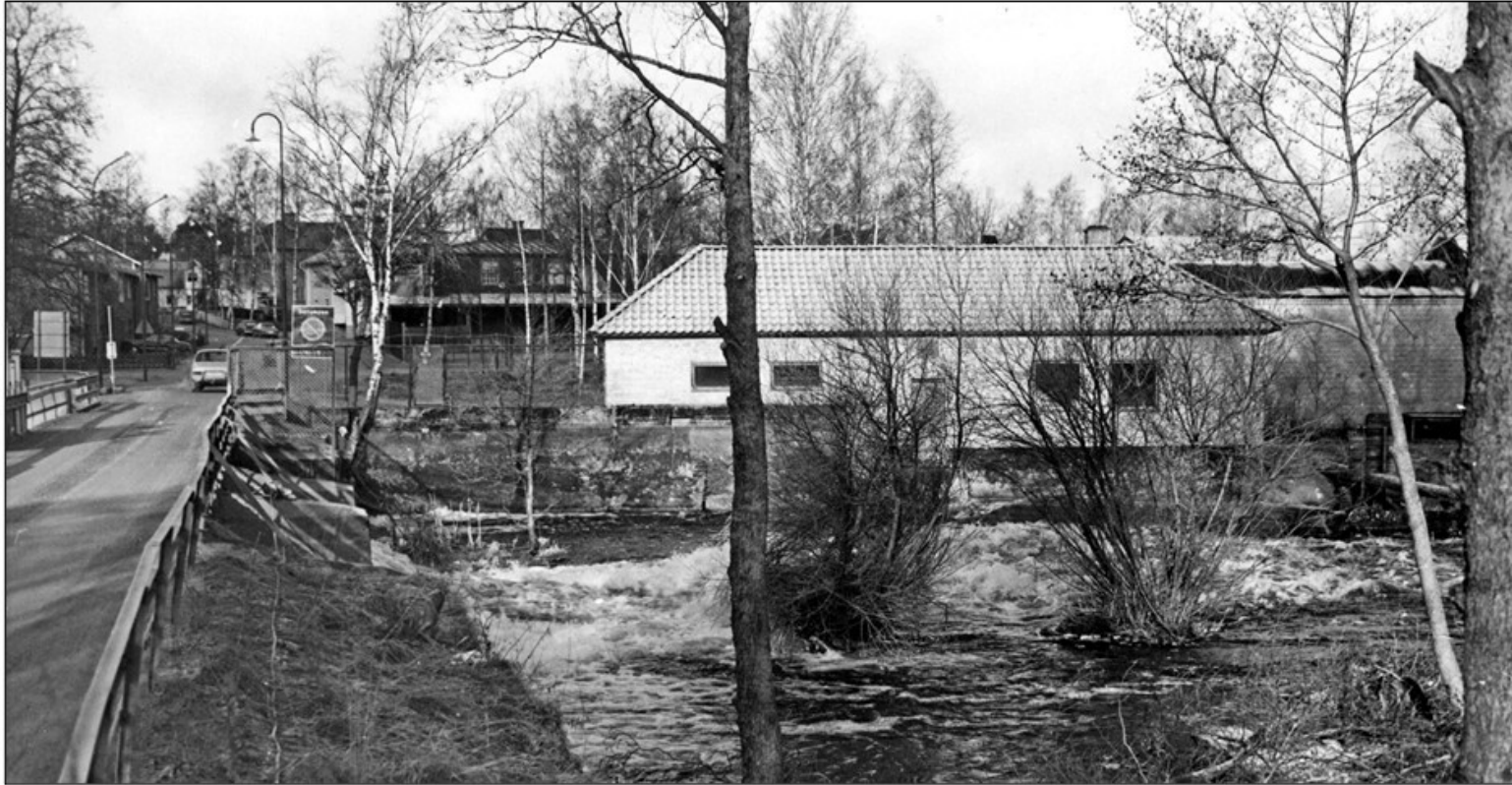
Kraftstationen vid Åsvallehult, mars 1975. Foto Karl-Erik Jansson.
