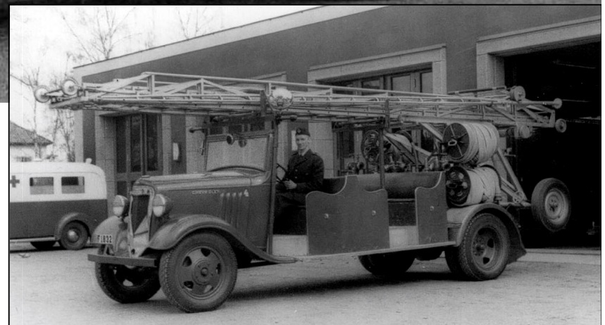
Fjärde utryckningsbilen, Chevrolet lastbil, reg. nr. F 1832. Köptes år 1938. På vilken – efter ombyggnad, fanns en 15 meters avbröstbar A-B-A stege
