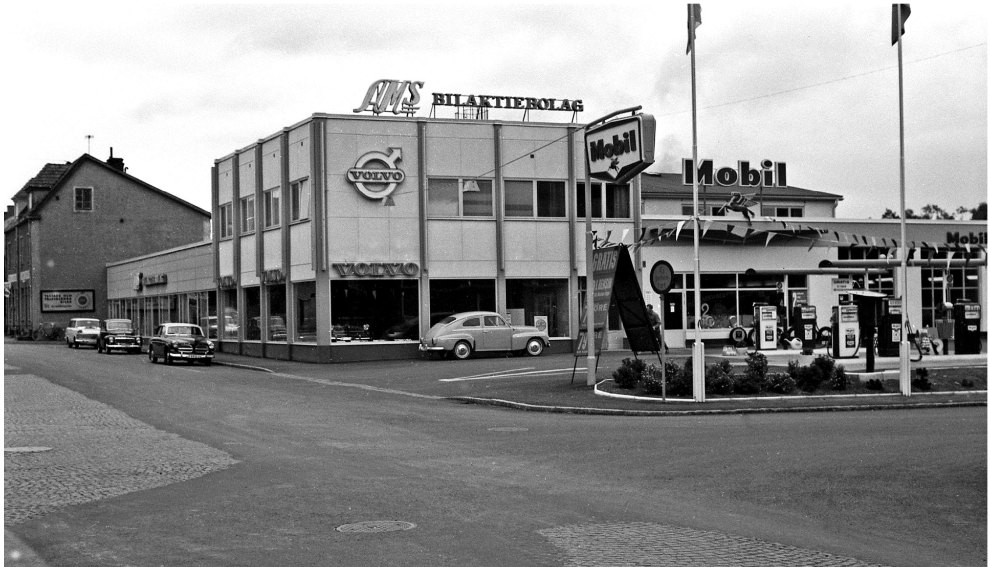
AM:s Bilaktiebolags nybyggnad, med fasaderna mot Ågatan – Missionsgatan.
