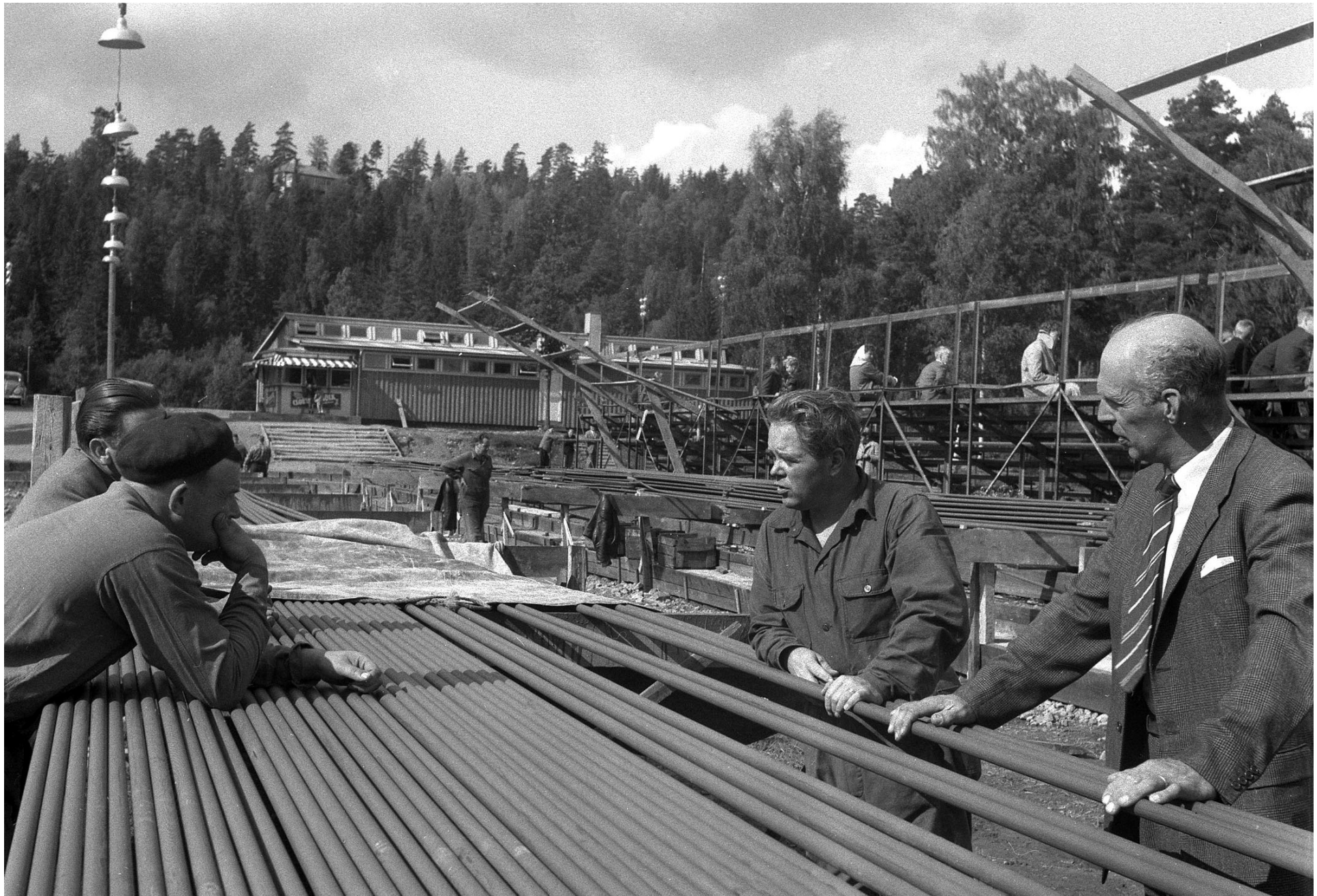
Det blev många meter rör som skulle svetsas och kontrolleras. Till höger på bilden ses byggmästare Jacobsson
