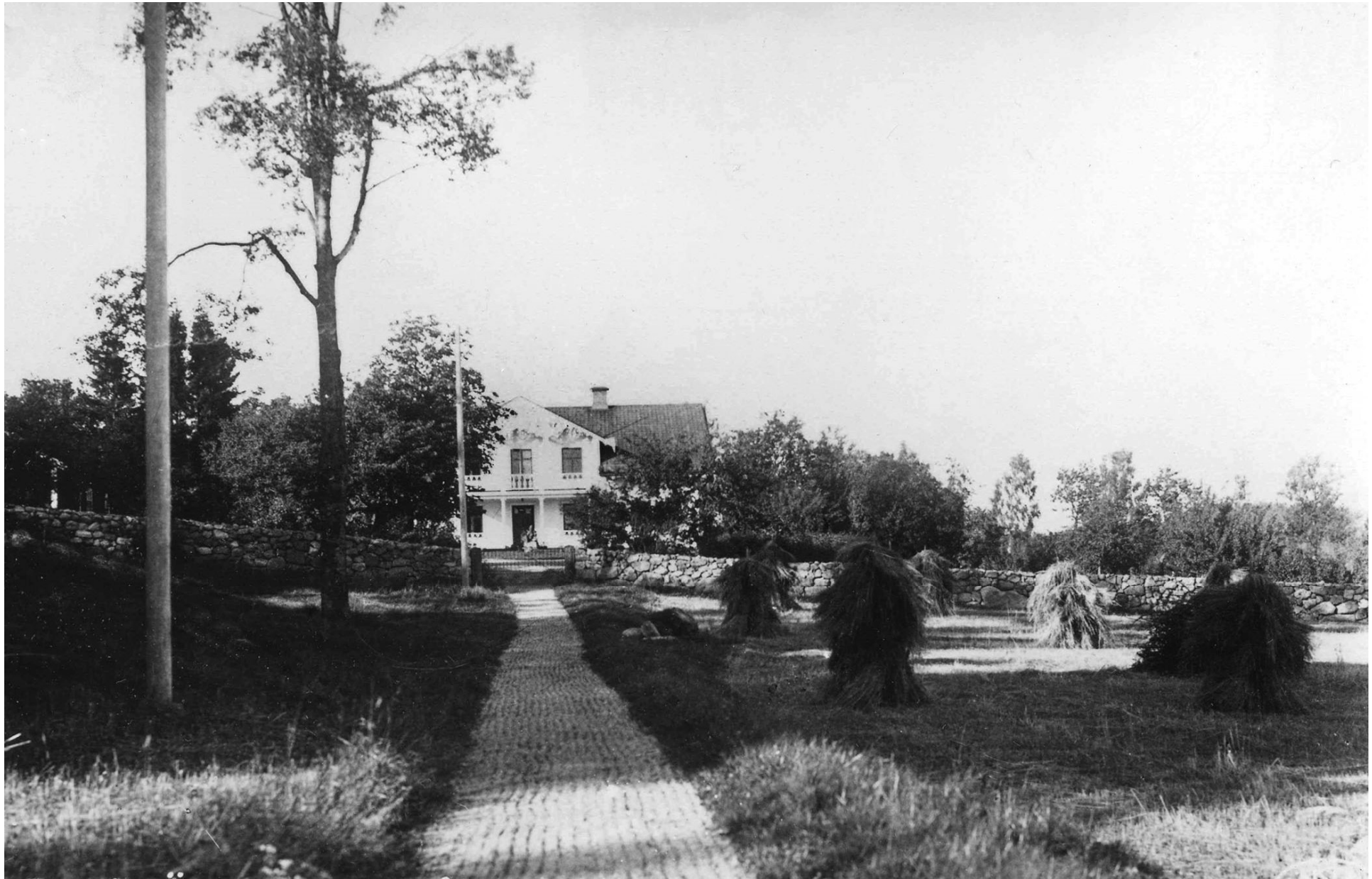
Den av major Hjalmar Åberg uppförda manbyggnaden vid Ängaryd. I röstet ses Åbergs och hans frus monogram samt årtalet 1881, då byggnaden uppfördes av makarna Åberg. År 1919 sålde Tranås stad Ängaryds manbyggnad till Säby församling som prästgård.
